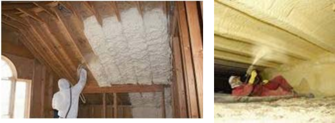
Isolering af PUR isolering, anvendt spray isolering
