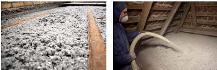
Isolering med cellulose isolering – ofte som granulat
