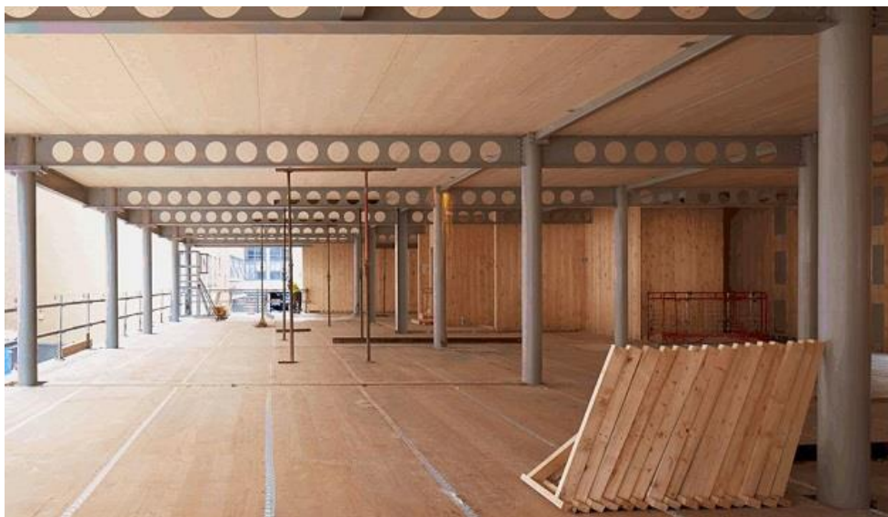
Billede: Etagedæk, Curtain Place
